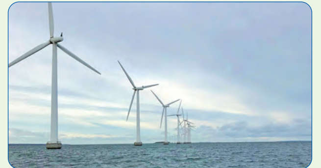
コペンハーゲン沖約3キロにあるミドルグルンデン洋上風力発電所
